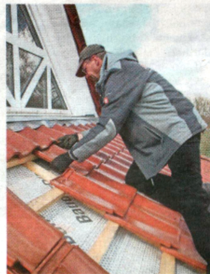
Mitarbeiter Enrico Kuenle beim Eindecken.
