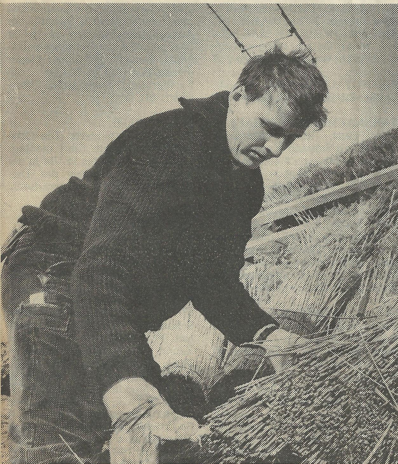
Jeder Handgriff sitzt bei ihm: Dirk Teßnow, 31 Jahre, bei der Arbeit auf der Baustelle in Körkwitz. Fotos: Peter Seemann
